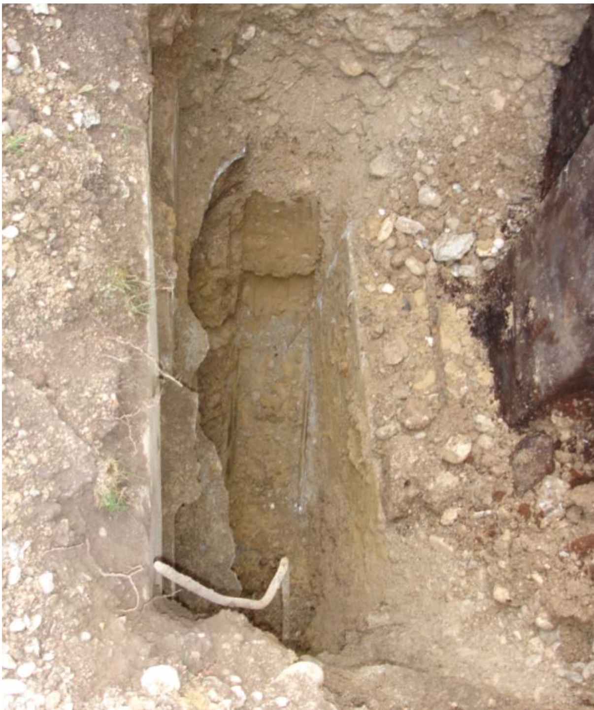
Pogled v dno sondažnega jaška na globini -2,50m Pogled v dno sondažnega jaška na globini -2,50m ob temelju obstoječe šole na SZ strani objekta
